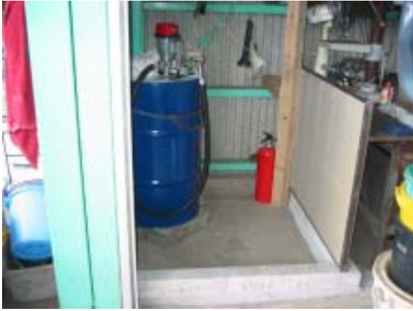
BDF貯蔵場所には消火器を設置し、周囲へ油漏れが起こらないようにコンクリートで囲まれています。BDFがなくなれば業者へ購入に行きます。
