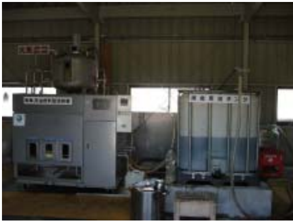
BDF化プラントの横には、1,000 ㍓の廃食用油用ポリタンクが設置され、ポンプによりプラントへ廃食用油を導入
