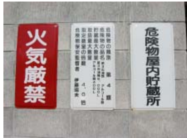
BDF精製等における危険物を貯蔵しているため、消防法の届出を行っている
