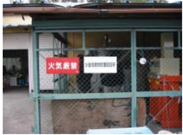
プラント設置場所は旧工場跡地をそのまま利用。消防法上の「危険物貯蔵取扱所」の取扱い
