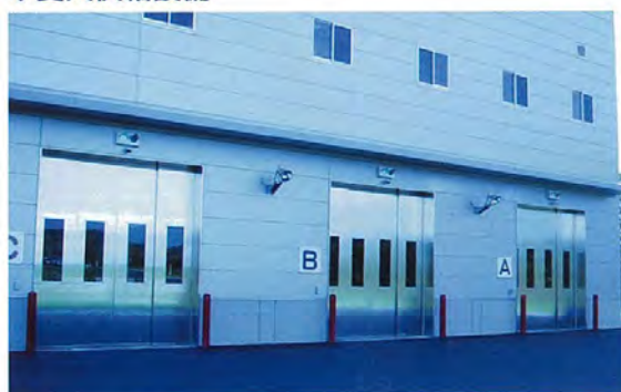
受入口 3系列、 車感センサー自動 開閉二重扉
