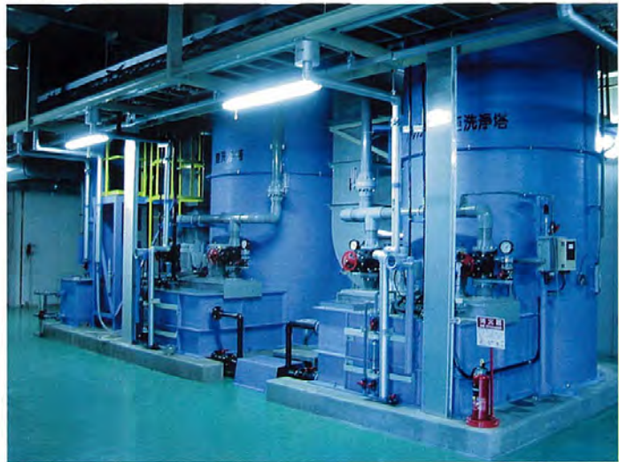
脱臭装置 高濃度臭気:生物脱臭+薬液洗浄+活性炭吸着 中濃度臭気:薬液洗浄+活性炭吸着 濃度臭気:活性炭吸着
