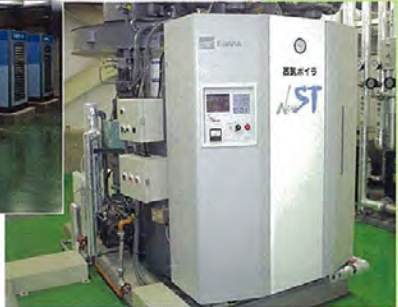
蒸気ボイラー バイオガスまたは重油を燃料として蒸気を発生させ、場内で利用します。
