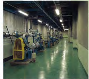
水槽上部(左) 地下ポンプ室(上) 処理量130m 3 /日、高負荷生物脱窒素処理方式+膜分離処理+高度処理を行い、河川放流します。
