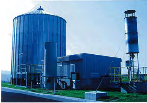
ガスホルダー、脱硫装置 ガスホルダー容量1,000m 3 、メタンガスを一時貯留して脱硫装置にて硫化水素を除去します。
