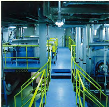
脱水乾燥室 汚泥脱水機3台、乾燥機1台
