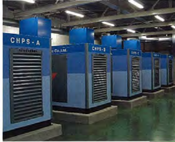
蒸気ボイラー バイオガスまたは重油を燃料として蒸気を発生させ、場内で利用します。
