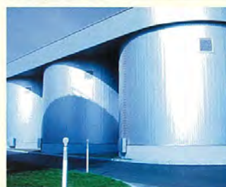
発酵槽屋内(上) 発酵槽屋外(左) メタン発酵槽 700㎡×3基、 中温発酵(35℃)、 滞留日数 20日間、 無動力攪拌方式
