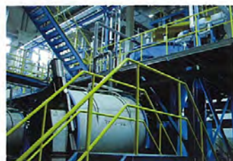
破碎選別装置(バルバー、マルチソータ) 生ごみをスラリー化するとともに、重量不適物や 軽量不適物を取り除きます。
