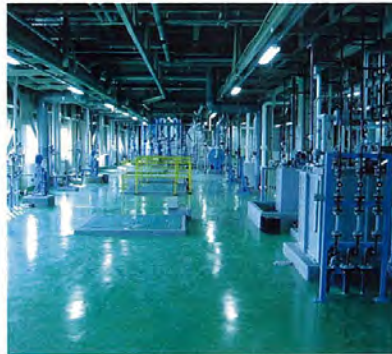
水槽上部(左) 地下ポンプ室(上) 処理量130m 3 /日、高負荷生物脱窒素処理方式+膜分離処理+高度処理を行い、河川放流します。
