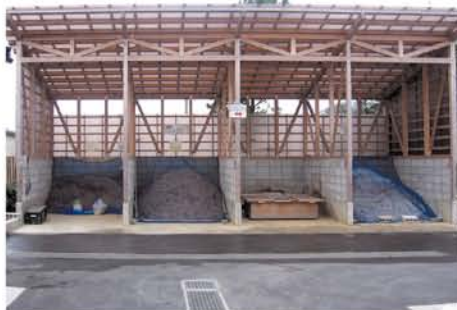
生ごみ堆肥舎(二次処理施設)
