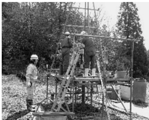
地質調査（ボーリング調査）
