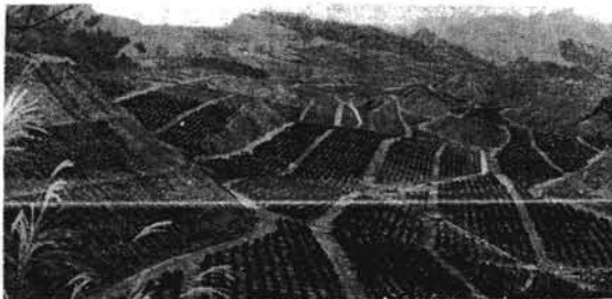
写真① 金山パイロット開口状態
