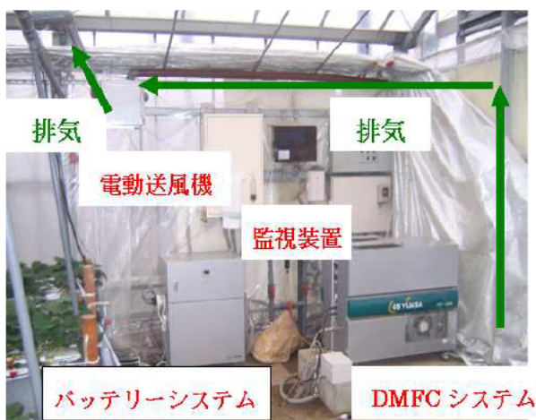
写真 1 燃料電池システムの構成
