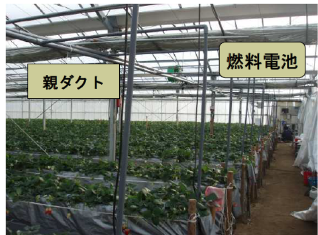
写真 2 送風ダクトの配管状況
