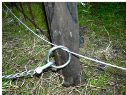
鋼線とリングの連結状況
