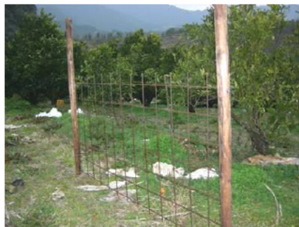
杭とワイヤーメッシュの設置状況
