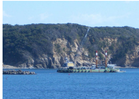
図19 船越前浜沖での設置の様子全景
