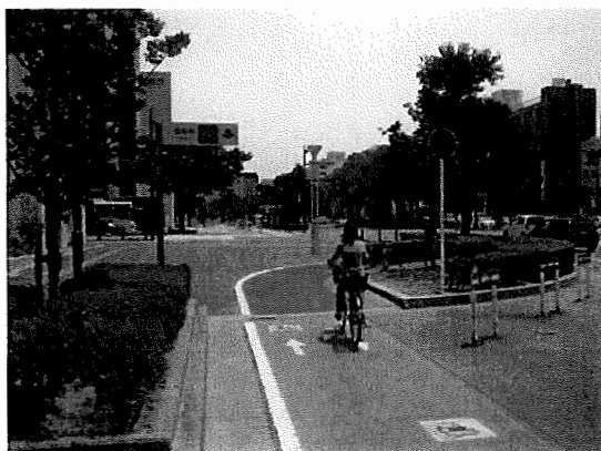
■自転車専用レーン（四日市市）
