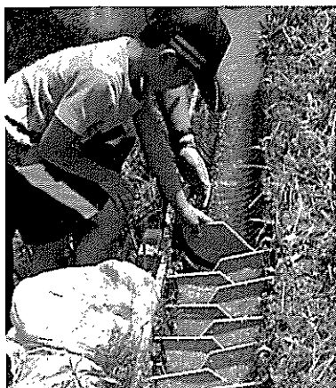
地元小学校の児童による水田魚道の設置
