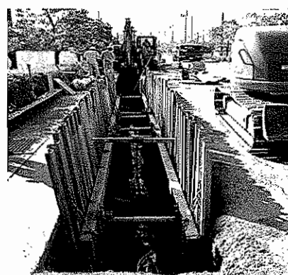
送水管布設工事
