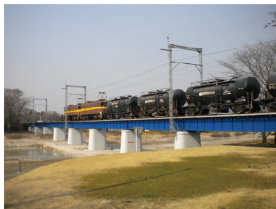
【同橋梁修繕後】
