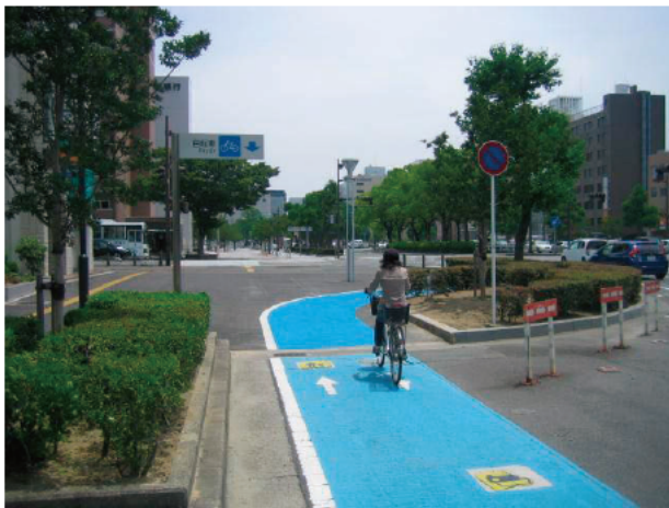
■自転車専用レーン(四日市市)
