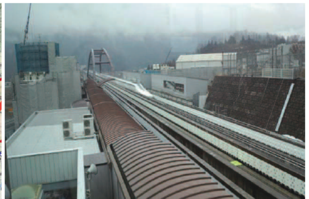
■超電導リニア走行試験の様子
