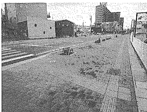
幅の広い歩道（県道久居停車場津線）
