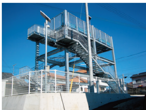
津波避難タワー (御浜町)
