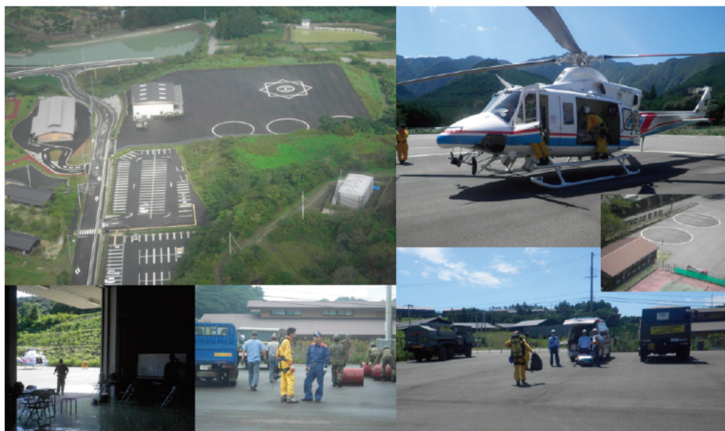
三重県広域防災拠点（東紀州拠点）
