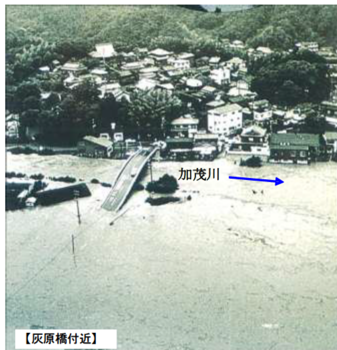
昭和 63 年 7 月洪水氾濫状況
