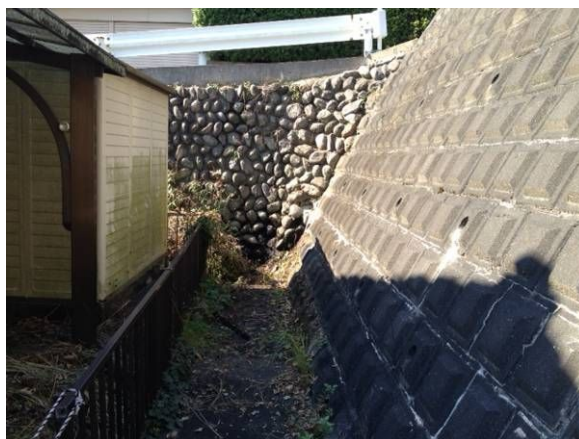
写真左側：旧公舎、右側：擁壁
