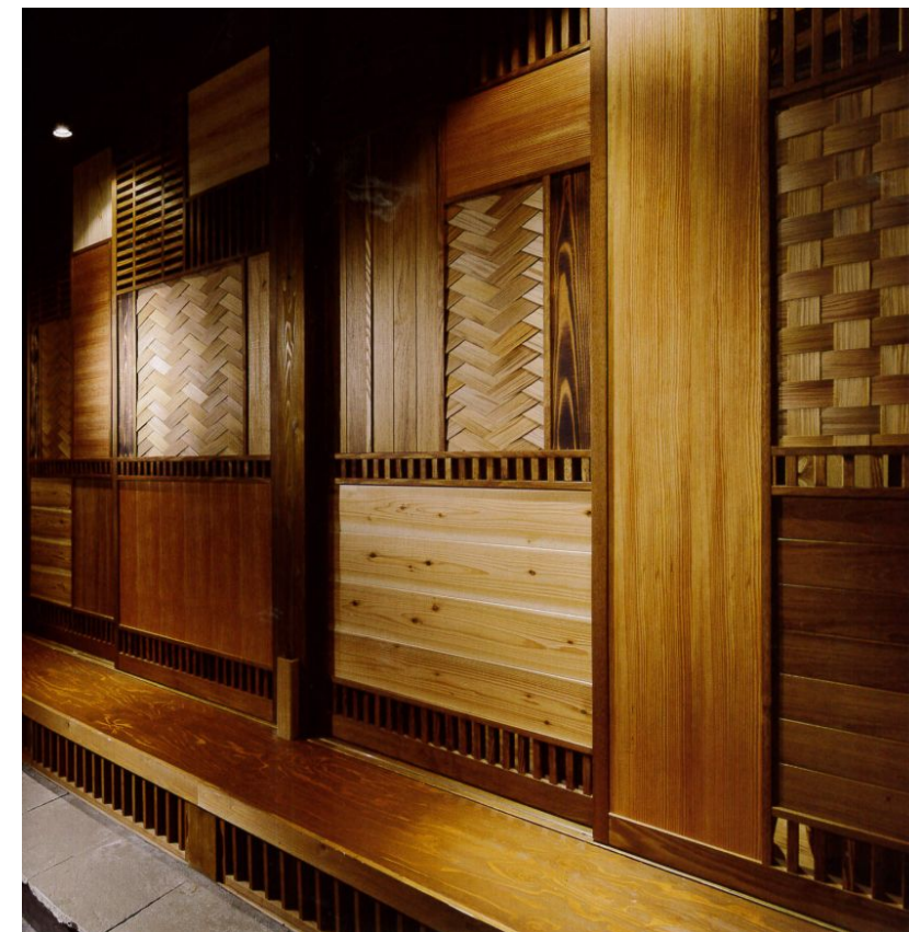
伝統技術(竹や組子)による壁面
