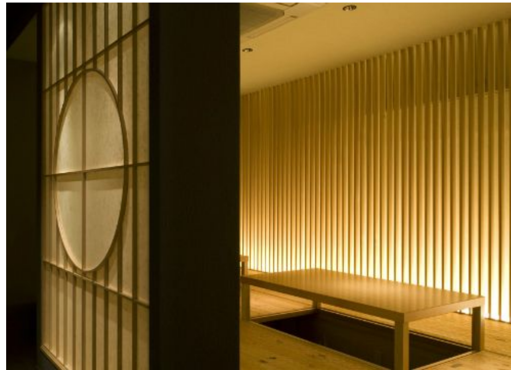
自然素材(木と和紙)の壁面と間接照明
