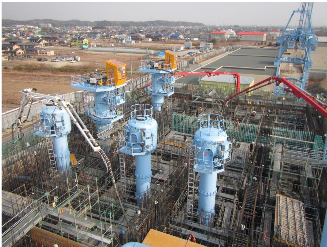
ポンプ機械棟(土木)建設工事
