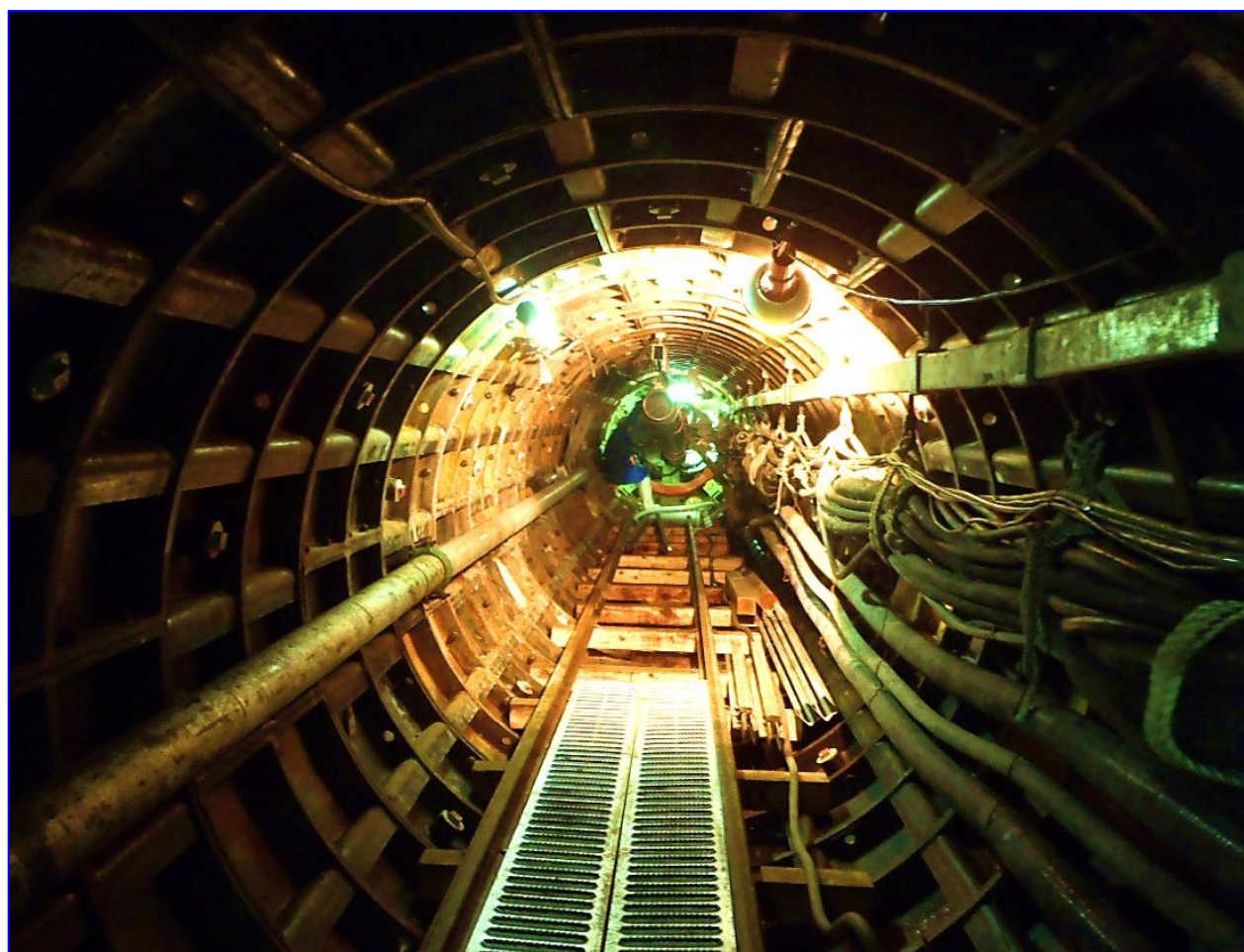
志登茂川幹線(第1工区)管渠工事
