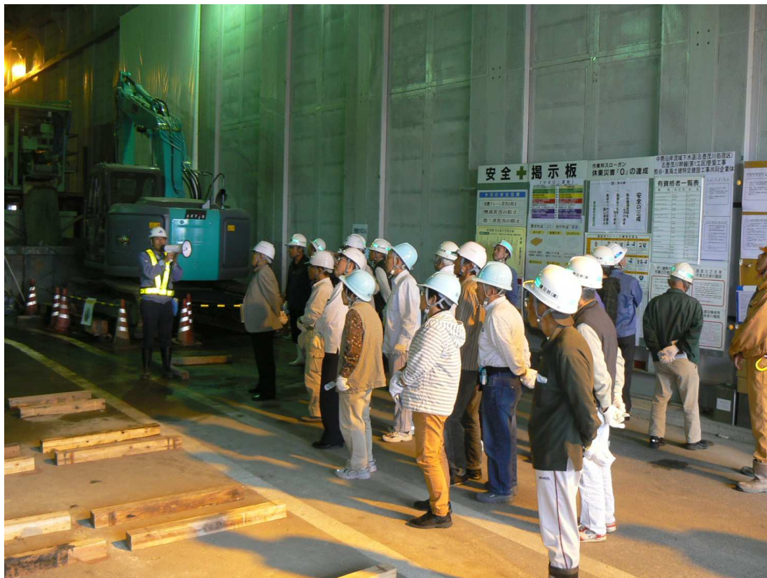
工事見学会の様子
