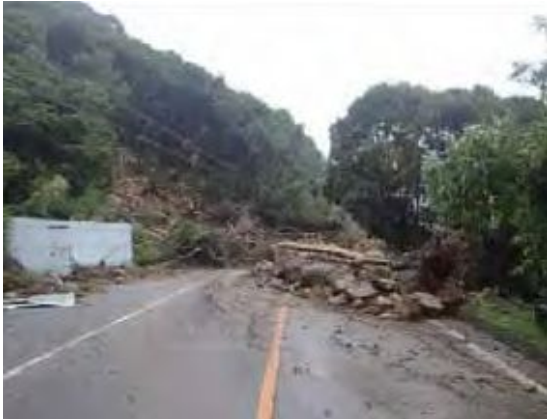
平成23年紀伊半島大水害: 三重県紀宝町出所) 三重県「紀伊半島大水害の記録」
