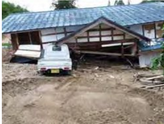
平成23年7月新潟・福島豪雨: 新潟県三条市出所) 新潟県「平成23年7月新潟・福島豪雨の記録」
