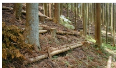
伐倒木を利用した土砂止の設置
