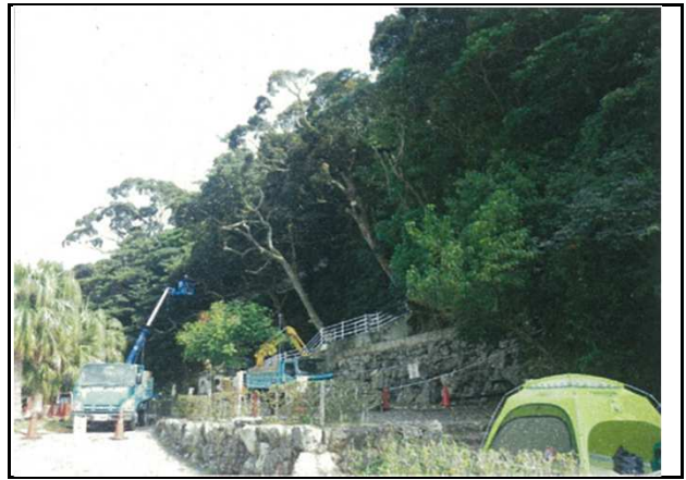
写真 対策2 暮らしに身近な森林づくり (大紀町) 生活環境林整備事業 【進捗:実施中】 施工中
