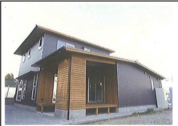
写真 対策4 木の薫る空間づくり (津市) 木材利用促進事業 【進捗:実施中】 補助対象住宅
