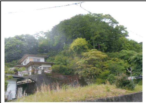
写真 対策2 暮らしに身近な森林づくり (紀北町) 危険木伐採事業 【進捗:実施中】 実施前
