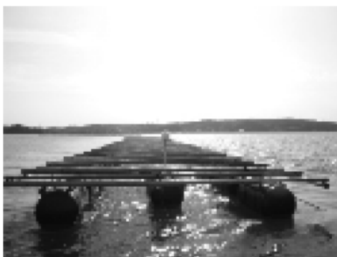
図 10. カキ筏設置による風波の抑制状況 右側が風上、左側が風下
