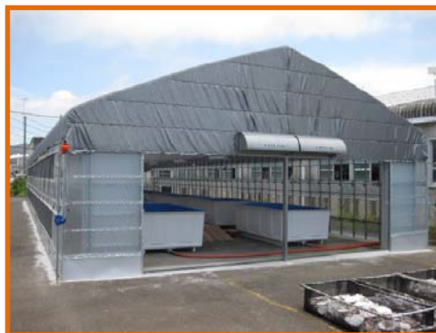
写真3 新たに整備したカキ人工採苗施設。
