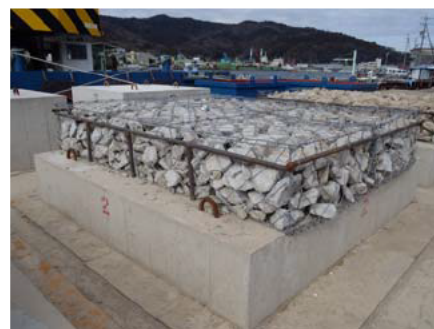
図 3. 製作中の試験魚礁 (直径 30cm 以下の石を使用)
