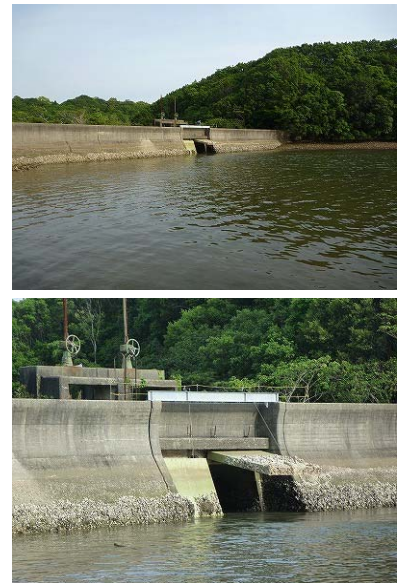
図 1. 石淵池前面の堤防（上）と開放した水門（下）
