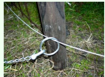
鋼線とリングの連結状況
