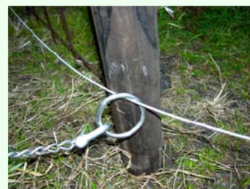
鋼線とリングの連結状況
