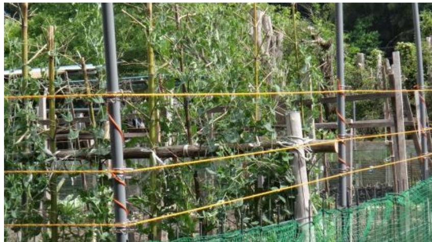
おじろ用心棒は、通常のワイヤーメッシュ柵の上部に通電式の支柱を用いた電気柵を設置した防護柵です。電気柵の支柱に電気を通すことでニホンザルが支柱を掴んだ際に電気ショックを与え登れなくします。
