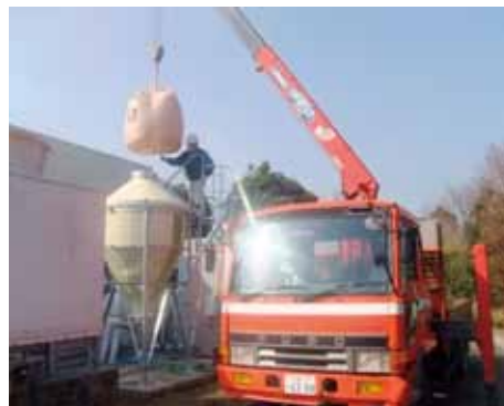
ペレットタンクへの燃料投入状況
