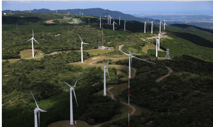
【風力発電：青山高原】 (写真提供：(株)青山高原ウィンドファーム)
