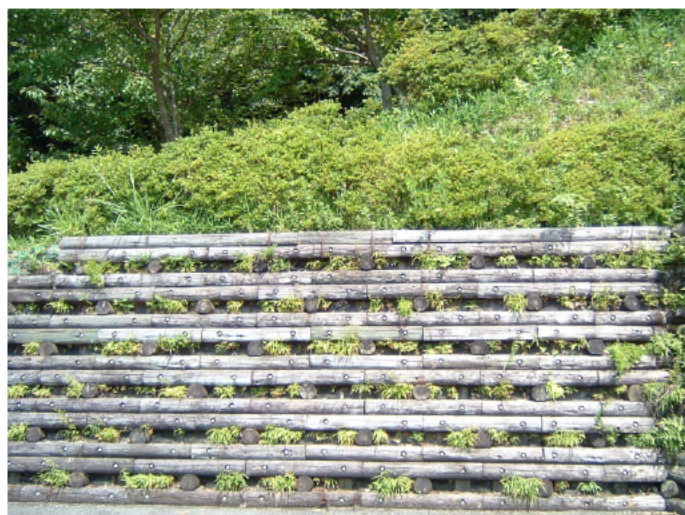
木製土留工 (伊勢市)
