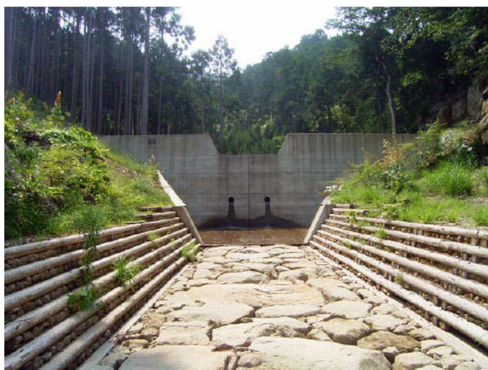
木製護岸工 (熊野市)
