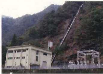
宮川第三発電所
