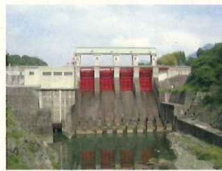
三瀬谷発電所
