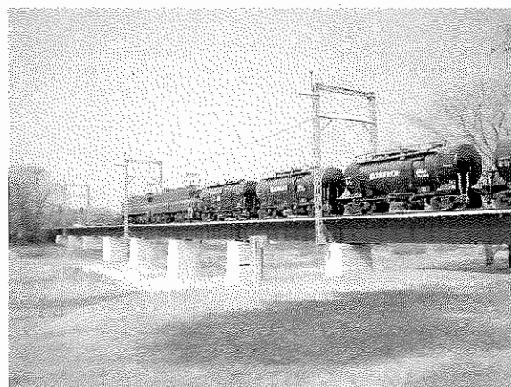
【同橋梁修繕後】
