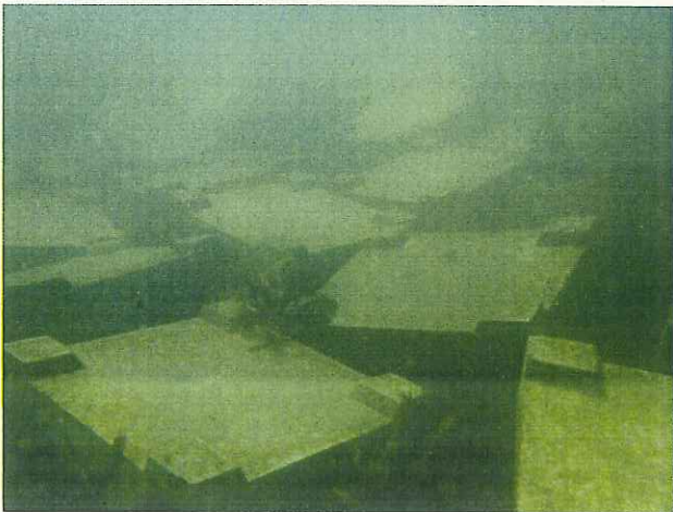
図3 海底に設置されたコンクリート板
