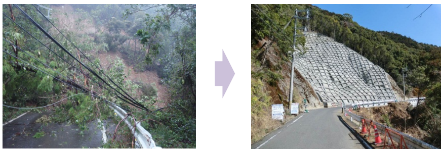
県道飛鳥日浦線（熊野市井戸町）（被災後、復旧後）
