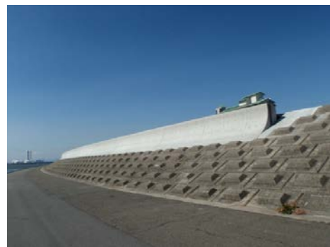
海岸堤防の嵩上げ（桑名市）
