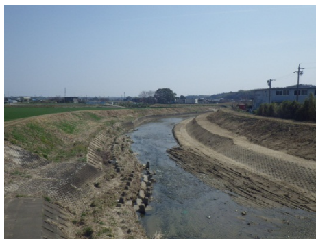
穴倉川堆積土砂の撤去（津市）
