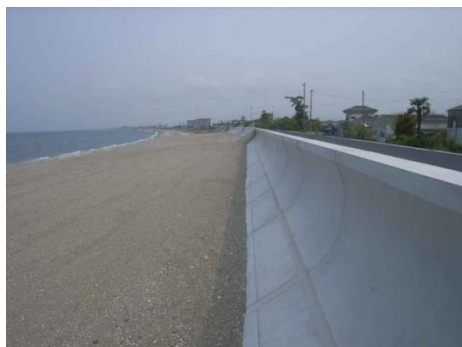
漁港海岸堤防の整備（伊勢市・明和町）
