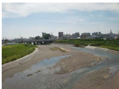
三滝川広域河川改修（四日市市）
