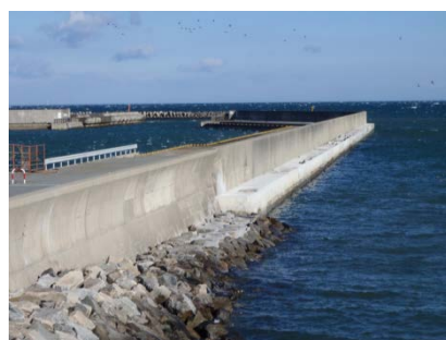
漁港の防波堤の整備による高潮対策（明和町）
