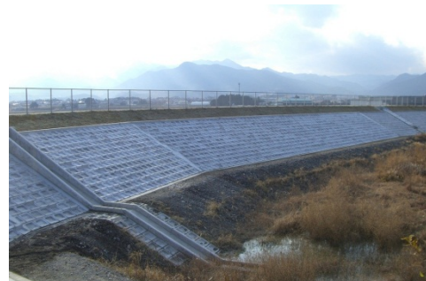
農業用ため池の洪水防止対策（津市）
