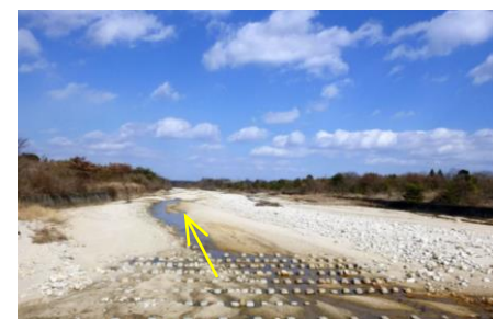
上流区間の状況 (18. 9k 付近)
