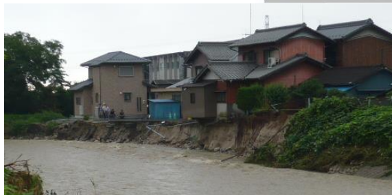
田光川の被災状況（平成20年9月）
