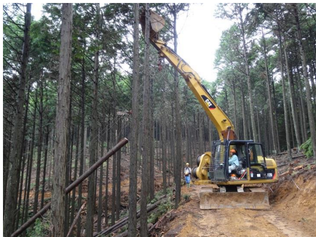
スイングヤードによる簡易架線集材
