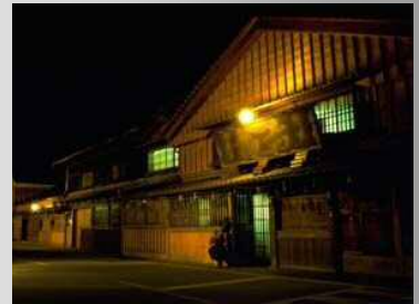
伝統的な様式の木造建築物の屋外照明が、温かみのある色調の光源となっている。(伊勢市)
