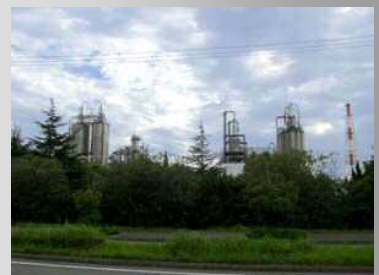
緑化と後退により、工作物の威圧感が軽減されている。（四日市市）
