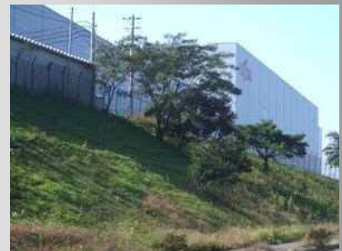
既存の樹木を残して、のり面が造成されている。（桑名市）
