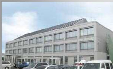
屋上の設備を飾り屋根で覆い、建築物に取り込んでいる。（鈴鹿市）
