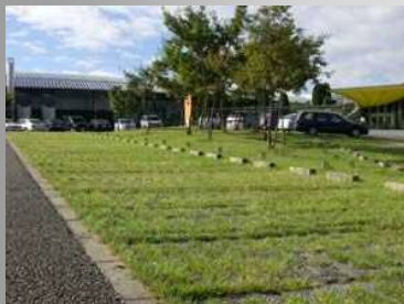
駐車場に緑化ブロックを敷設するとともに、駐車スペースの間に樹木を配置している。（岐阜県各務原市）
