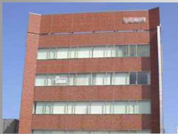
屋上に設置されている設備を外壁と類似の素材で覆い建築物と調和している。（津市）
