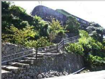
地場産の石材を使用した擁壁が自然に溶け込んでいる。（志摩市）
