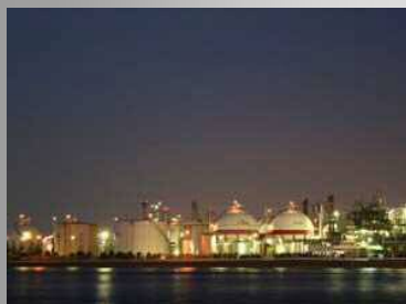
夜間照明が昼間とは異なった工場の印象を与えている。(四日市市)
