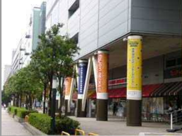
賑わいの演出を1階のみとし、上層階は落ち着いた形態や色彩となっている。（東京都港区）
