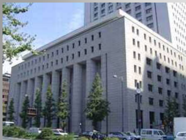
旧建物のファサードが復元され、当時の趣を出している。 (東京都中央区)
