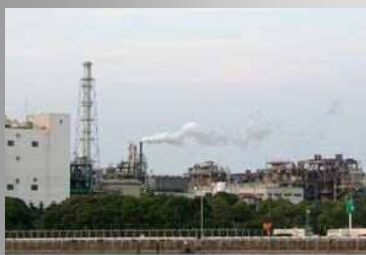
工作物の高さを考慮した樹種が選定されている。（四日市市）
