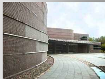
自然の色を採用し、壁面全体に濃淡の変化をつけている。（明和町）
