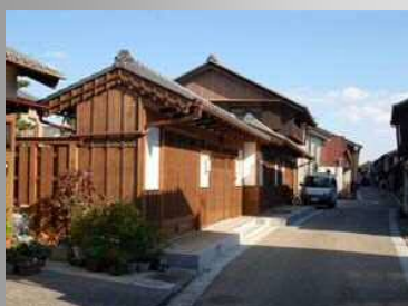
門扉を設け、周りの建物との連続性を図っている。（亀山市）
