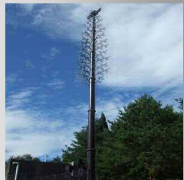
周辺の眺望景観を阻害しないような携帯電話基地局のデザインとしている。（岐阜県高山市）
