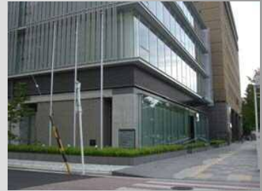
敷地境界線から後退し、圧迫感が軽減されている。(四日市市)
