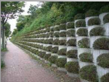
長いのり面に緑化可能な構造物が使われ、潤いのあるのり面になっている。（伊勢市）
