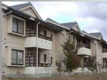
空調設備等が外部から見えないうくりとなっている。（伊賀市）
