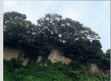
露出した地肌がツタ類に覆われ、緑化されている。（四日市市）
