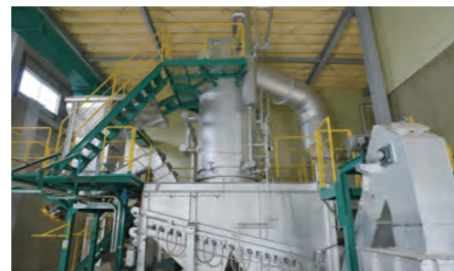
バイオマスボイラ設備の一部
