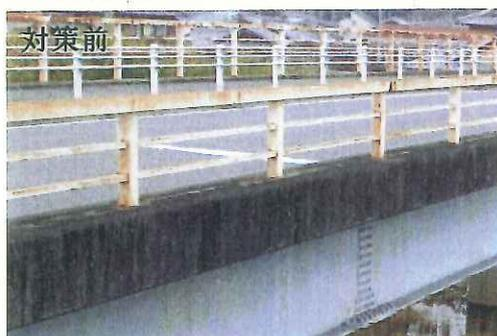
老朽化により高欄、主桁のサビが進行
