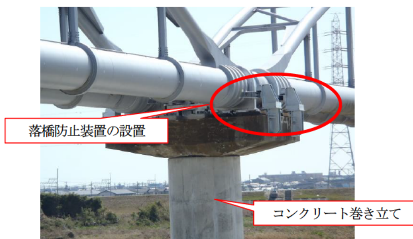
耐震化を行った鈴鹿川第2水管橋
