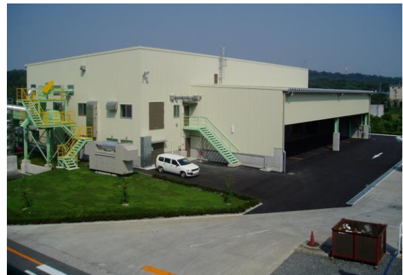
RDF貯蔵施設
