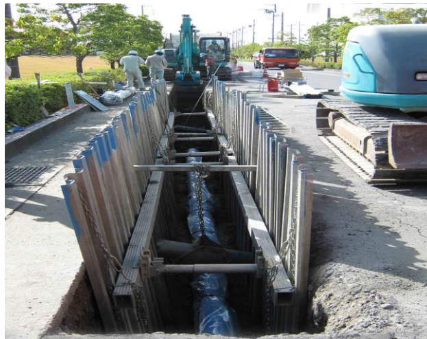
管路布設替えの状況
