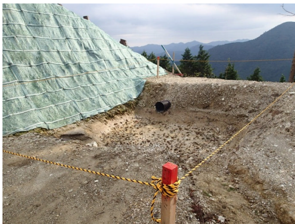
写真 2.3.1-1 仮設沈砂マスの設置状況（風車機No.10 平成 27 年 10 月 6 日）
