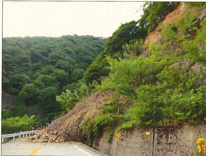
○崩壊土砂の状況 延長約38m (路面幅員: 約9m)
