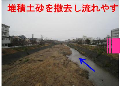
堆積土砂を撤去し流れやすくした (0k800地点)
