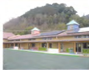
木造公共施設の整備(多気町)
