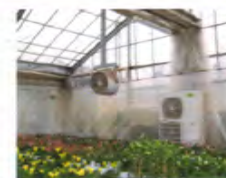
※ビニールなどの被覆設備と循環扇の導入により、暖房効率を高めて燃油を節約
