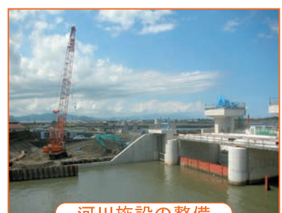
河川施設の整備
