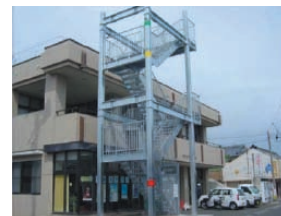
外付階段整備
