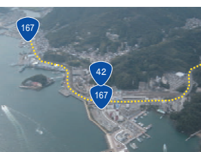
▲鳥羽市街の状況（鳥羽市駅前） 海岸の直背後を国道が走り、津波による道路寸断の恐れがある。
