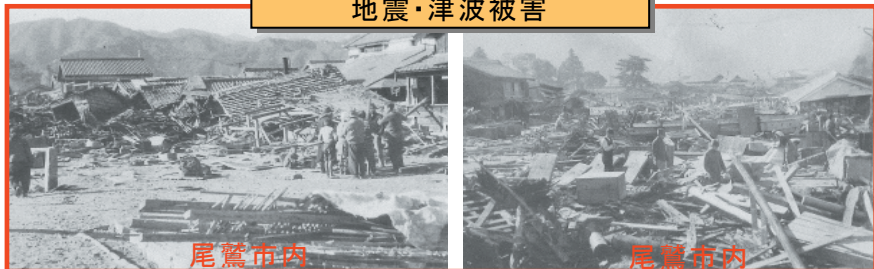
東南海地震(昭和19年)の地震・津波被害
