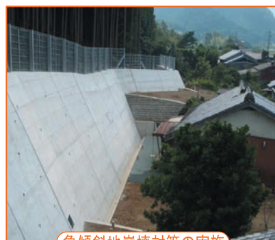
急傾斜地崩壊対策の実施
