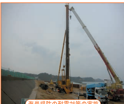
海岸堤防の耐震対策の実施
