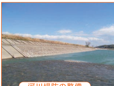
河川堤防の整備
