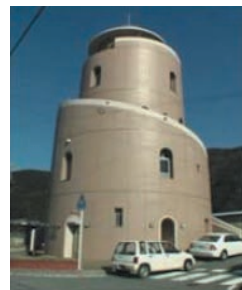
津波避難タワーの整備
