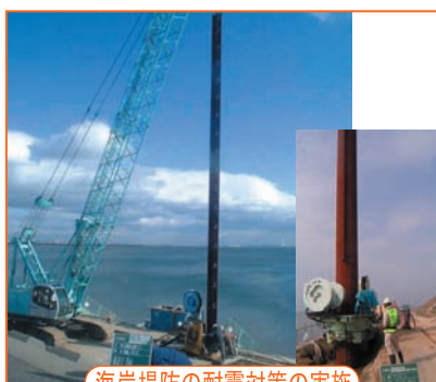
海岸堤防の耐震対策の実施
