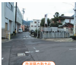
防潮扉の動力化
