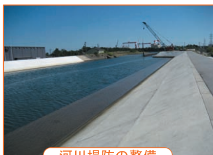
河川堤防の整備
