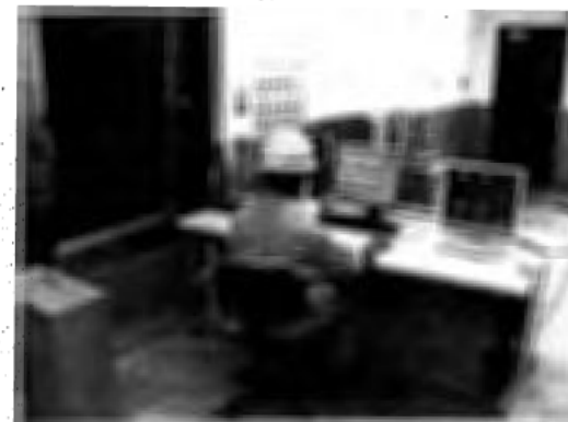
クレーン操作室
